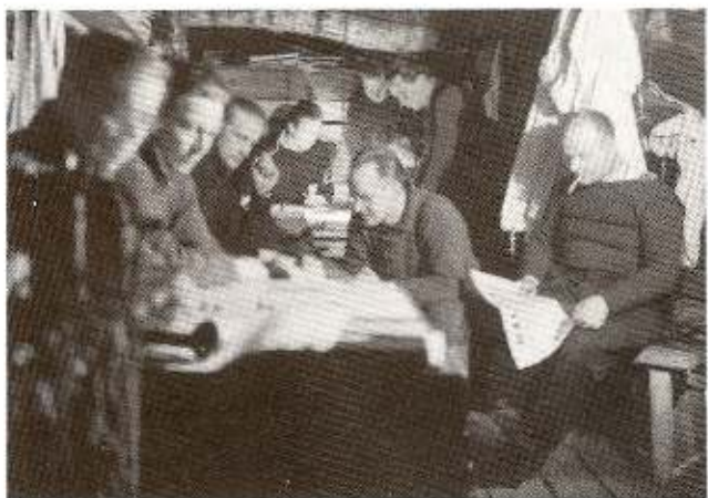
Patterin tasotyöskentelyä Taipaleessa 1940.
